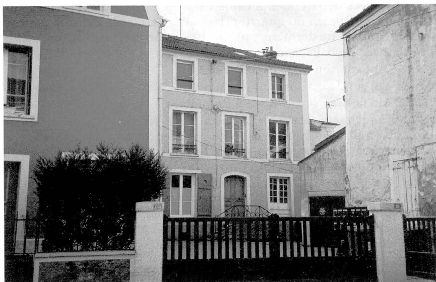
La maison portant le n° 10 de la rue de la Pêcherie, seconde étude probable de M e Martin. (Cl. de l'auteur.)
