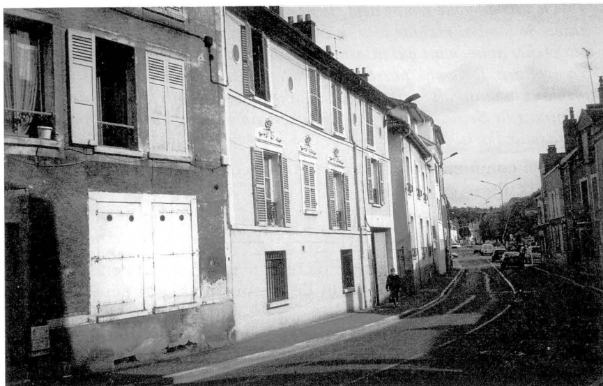
La maison portant le n° 13 de la rue de la Pêcherie, première étude de M e Martin. (Cl. de l'auteur.)
